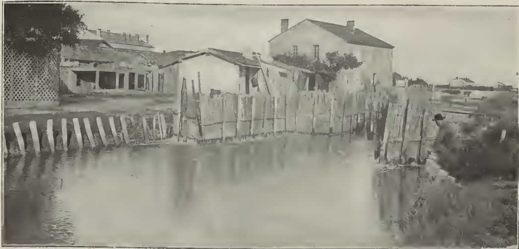
Canal cercado de estacas que pone en comunicación el mar con las salinas
